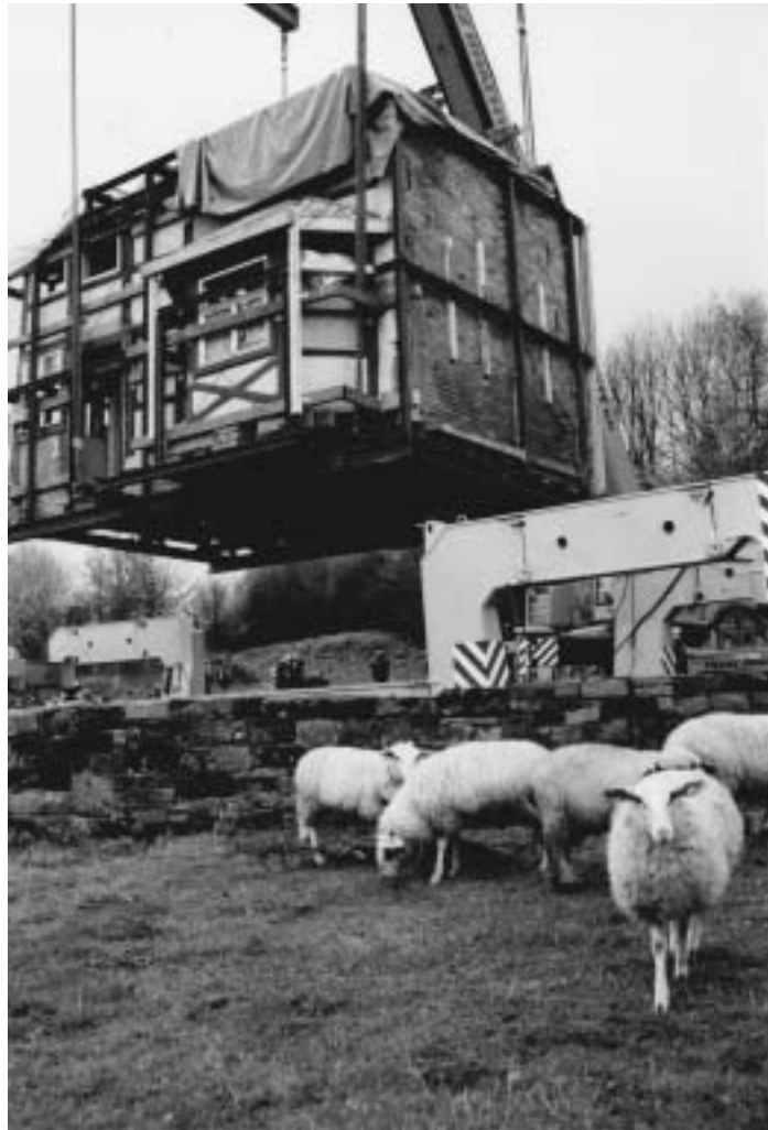
Abb. 4: Translozierung des Hauses aus Ovenhausen ins Westfälische Freilichtmuseum Detmold am 18./19. November 2000. Abladen des vorderen Gebäudeteils im Freilichtmuseum (Foto: Landschaftsverband Westfalen-Lippe, Fischer)
